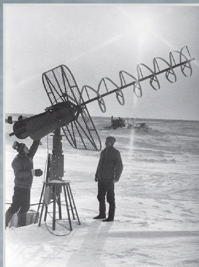
Система «Уран» для приема информации с ИСЗ на СП-28. 1987 г.
